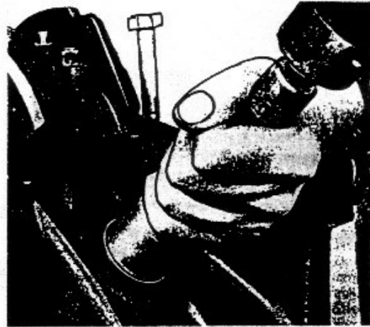
15.10 Eine Fassung und ein Hammer können benutzt werden, um die neuen weichen Stopfen im Block zu installieren
