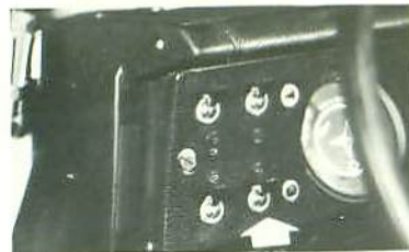
Fig. 22.—Interruptor de la calefacción
