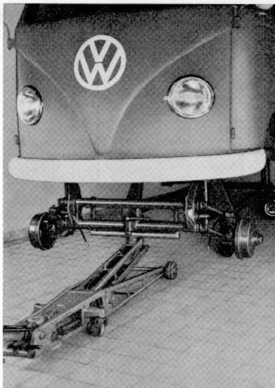
12 - Wagenheber senken und Achse ausfahren.
